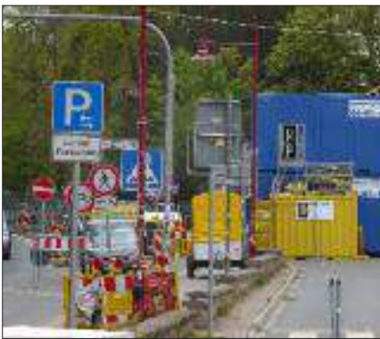
Baustellen neben Baustellen
