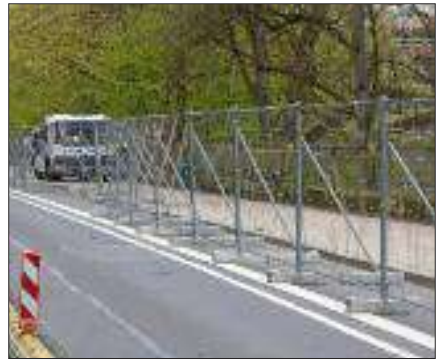
Absperrung für die Mauerbefestigung
