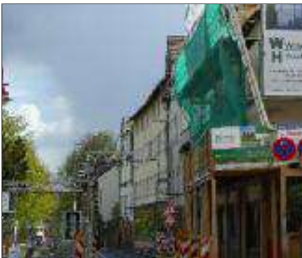
Immer noch Baustelle
