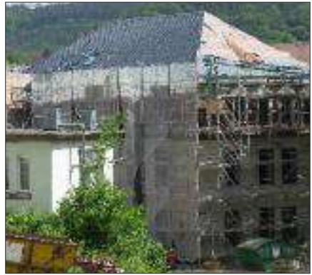
Neues Mansarddach des ehemaligen Klinikgebäudes
