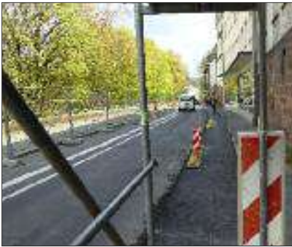
Provisorisch verbreiteter Gehweg
