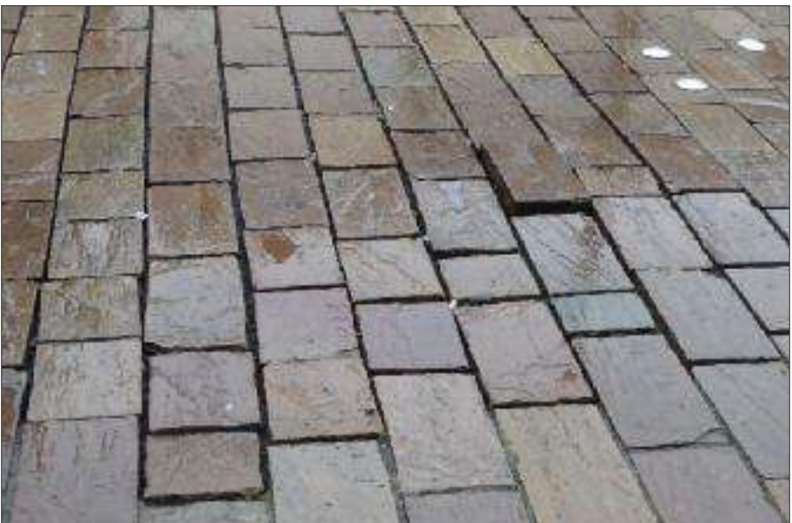
Neuer Straßenbelag nach 2 Jahren
